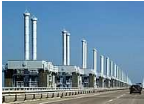
Los diques sirven para evitar la invasión del mar. En la foto uno de los diques Delta, en Holanda ©Wikipedia
