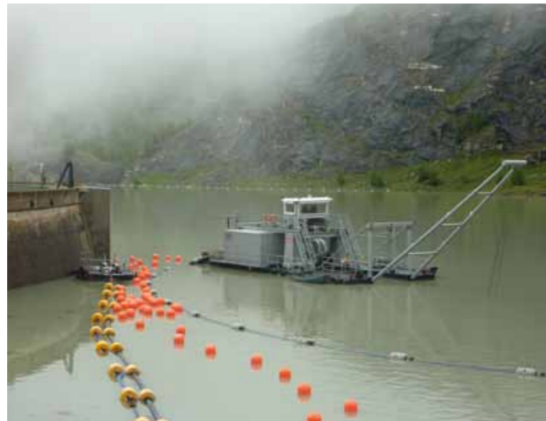
De Vis Groep houdt een Oostenrijks stuwmeer met een elektrische zuiger op diepte.
